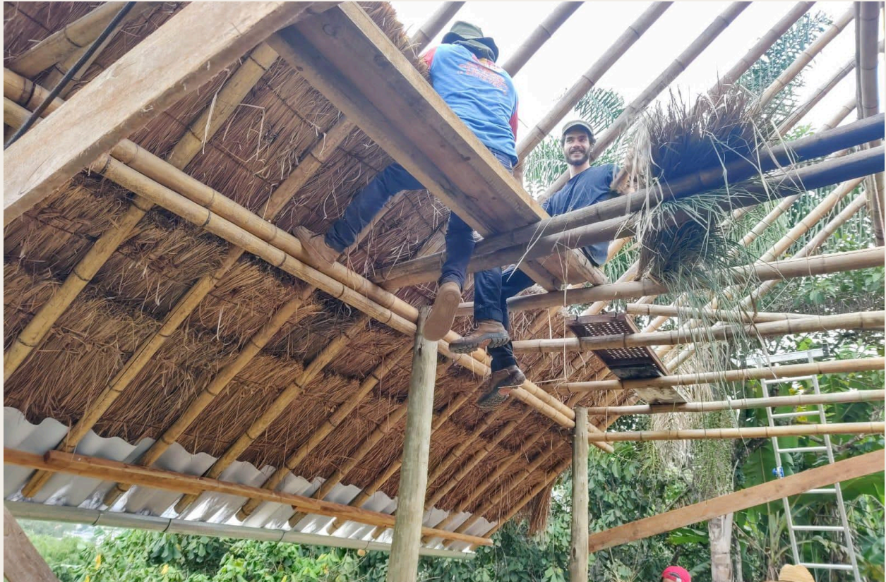
Construção de cobertura com bambu e palha. Foto: Arquivo MST-SP e FAUUSP.
