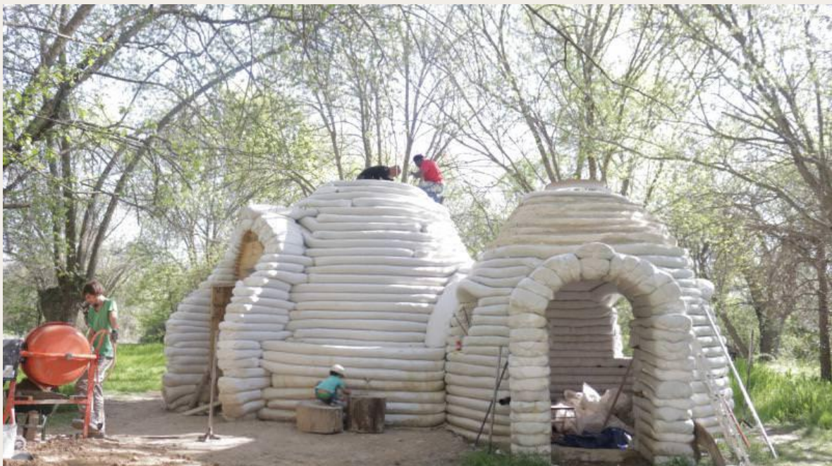
Construção em superadobe.
