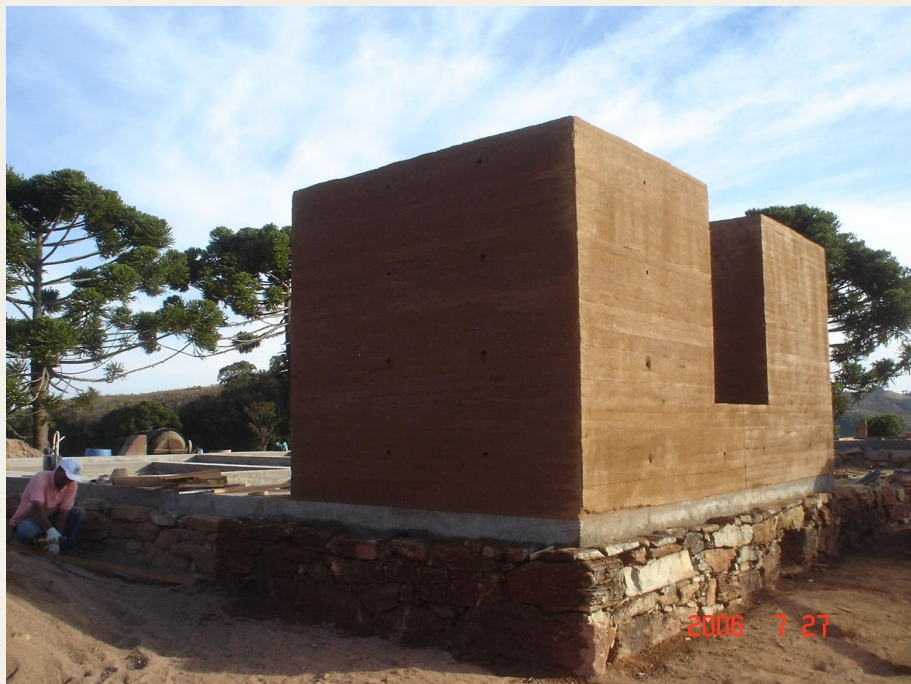
Paredes em taipa de pilão.
