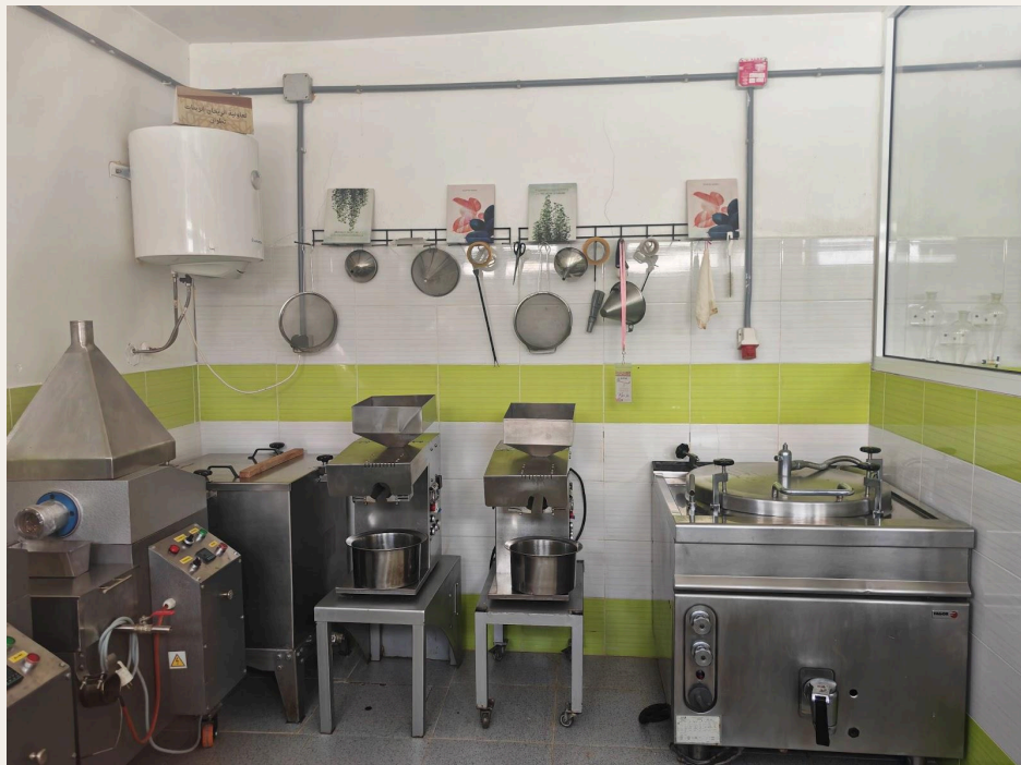
Cámara de extracción. Foto: Xiao Chenjuan.
