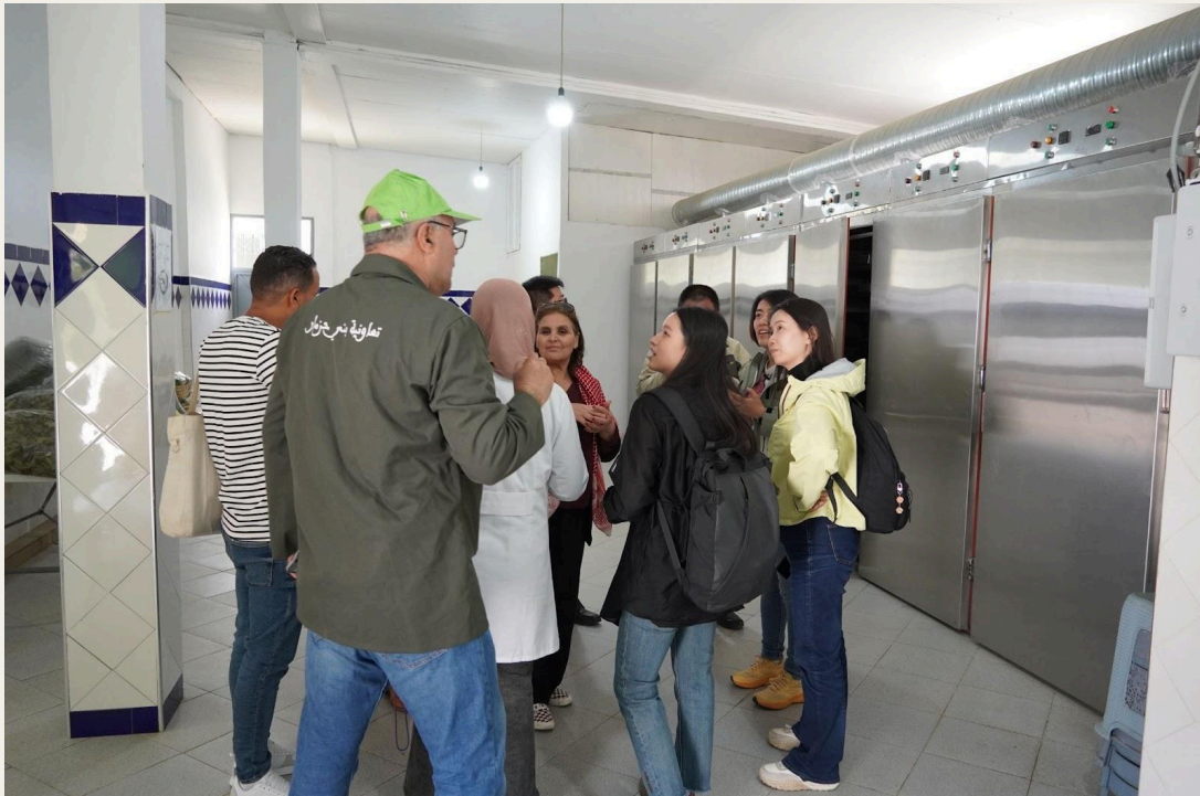
Instalaciones de secado. Fotos: Xiao Chenjuan.
