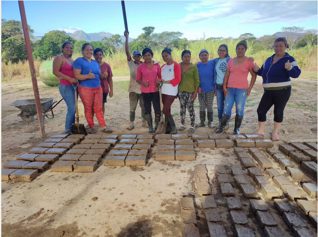
Elaboración de bloques de adobe por las mujeres para la construcción del Trapiche Comunal. Comuna 5 Fortalezas de la Revolución Bolivariana. Fuente: elaboración propia.
