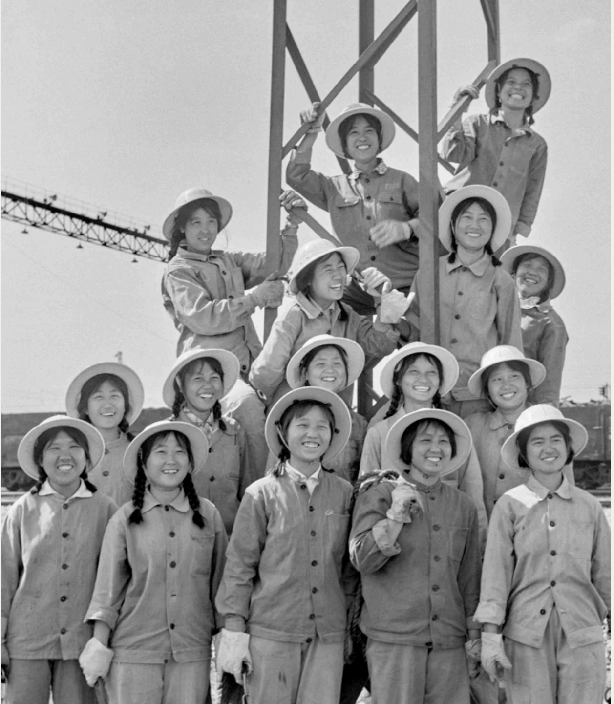
下大上小的正三角形结构稳定画面，展现新中国女性劳动者风采。1975年7月，在四川参加宝成铁路电气化建设工程的铁道部电化工程局电化工程处四队一分队女工班的工人。新华社记者 吴祖政 摄。
