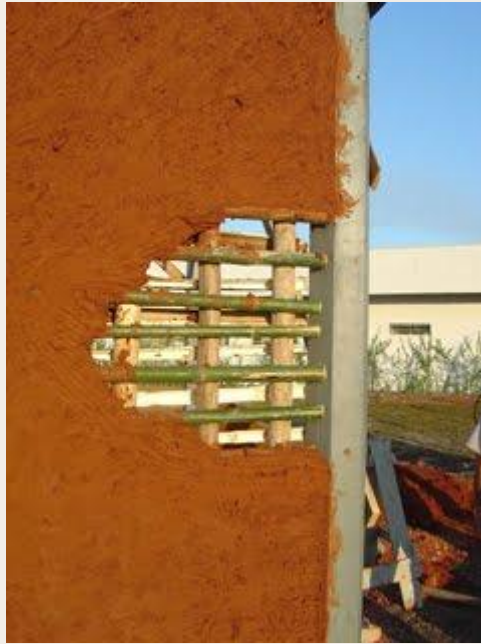
Detalle de muro construido con tierra apisonada manualmente (bambú-a-pique).
