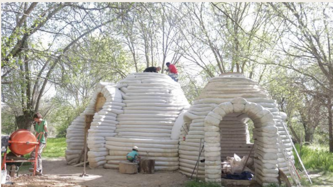
Construcción en superadobe.
