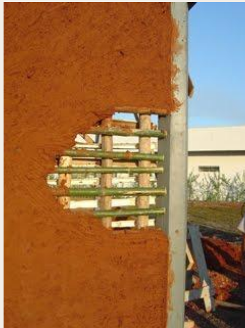
用灰篱笆（竹篱笆）砌成的墙的细节。
