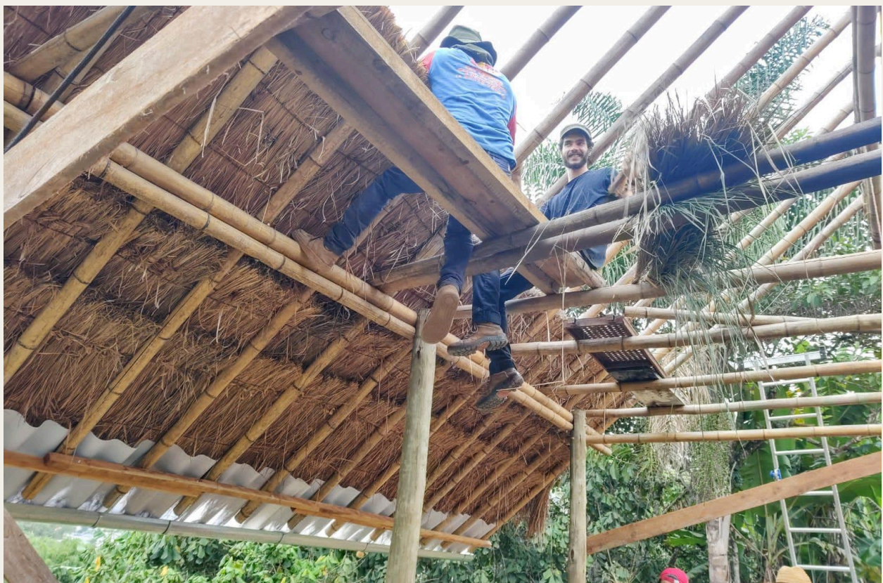
Construcción de techo con bambú y paja. Foto: Archivo MST-SP y FAUUSP.
